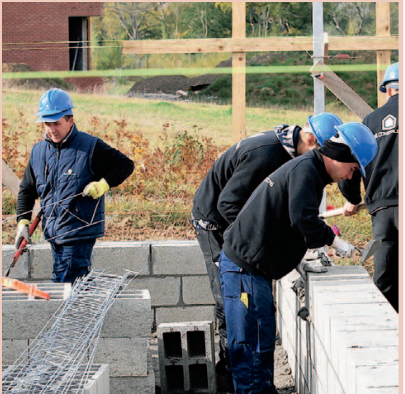
Pour mieux répondre aux besoins liés à l'écoconstruction, les patrons ont dû envoyer leurs ouvriers suivre des formations. Les maisons passives ou à basse énergie demandent, en effet, un savoir-faire particulier. © DÔME CONSTRUCTIONS.
